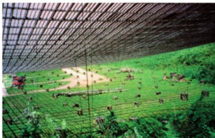
▲ Перфорированные алюминиевые панели, из которых сложена поверхность отражателя, уложены на прочную сетку из нержавеющей стали, подвешенную с помощью системы тросов на высоте нескольких метров над грунтом, укрытым тропической растительностью.
