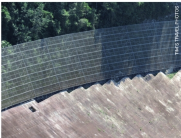
▲ Решетчатое ограждение на краю главной антенны. Отражающая поверхность из перфорированного алюминия постоянно покрывается загрязнениями и лишайниками (впрочем, практически не влияющими на качество приема), поэтому ее участки регулярно чистят, однако произвести ее «всеобщую очистку» из-за больших размеров пока не удавалось.
