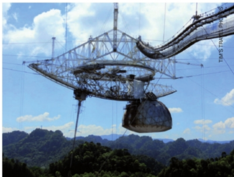
▲ Подвесная поворотная конструкция с закрепленным на ней куполом диаметром 29 м, в котором находится 27-метровое вогнутое вторичное зеркало (установлено в 1997 г.) и комплекс приемопередающей аппаратуры. Справа вверху виден переходный мостик для обслуживающего персонала.
